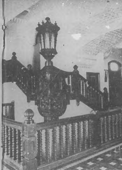
Un tramo de la valiosa escalera de caoba y acana
